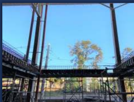
Travamento das vigas
