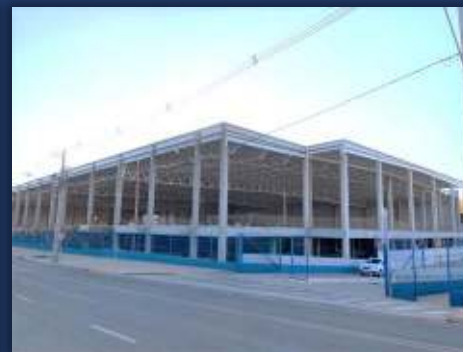
Remoção do tapume na fachada lateral
