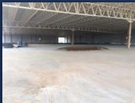
Segundo pano de laje
